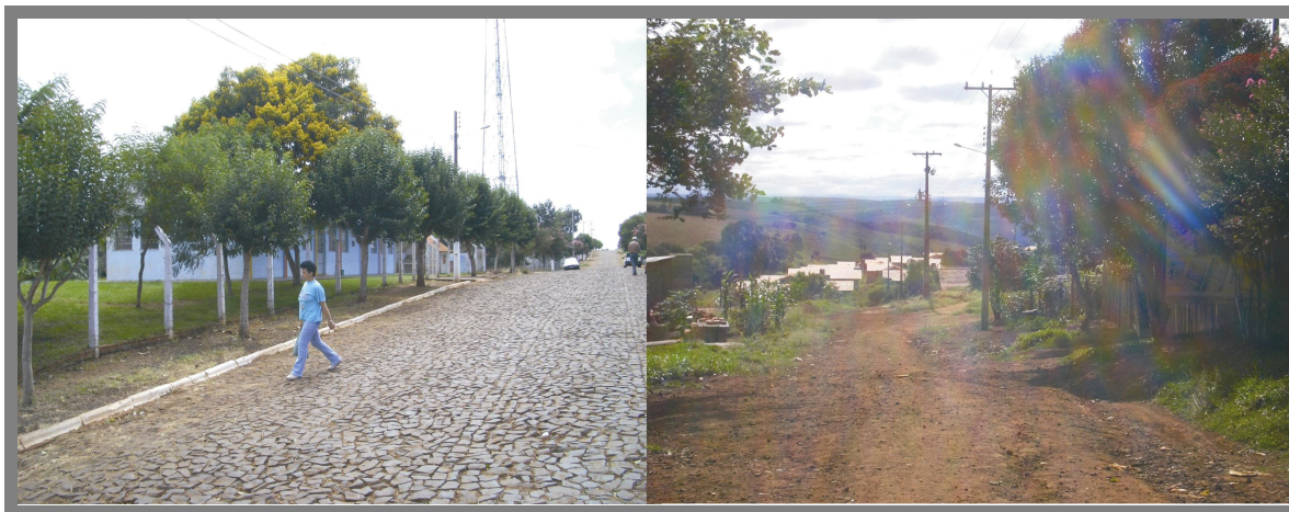
FIGURA 3.4.9 ASPECTOS DA PAVIMENTAÇÃO
