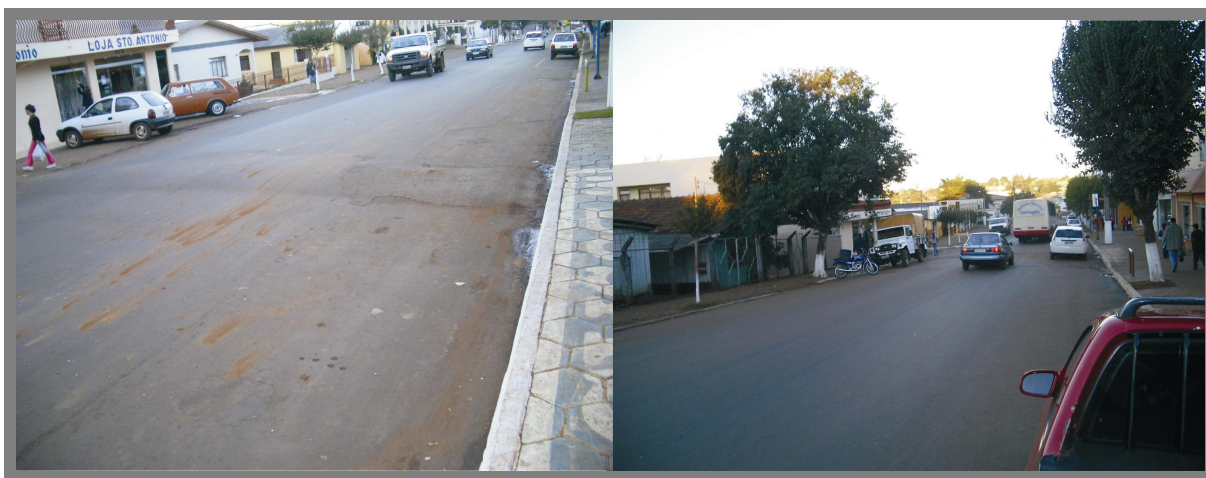
FIGURA 3.4.8 ASPECTOS DO SISTEMA VIÁRIO
